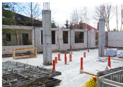
Budowa ZUM przy ul. Granicznej w Nadarzynie
