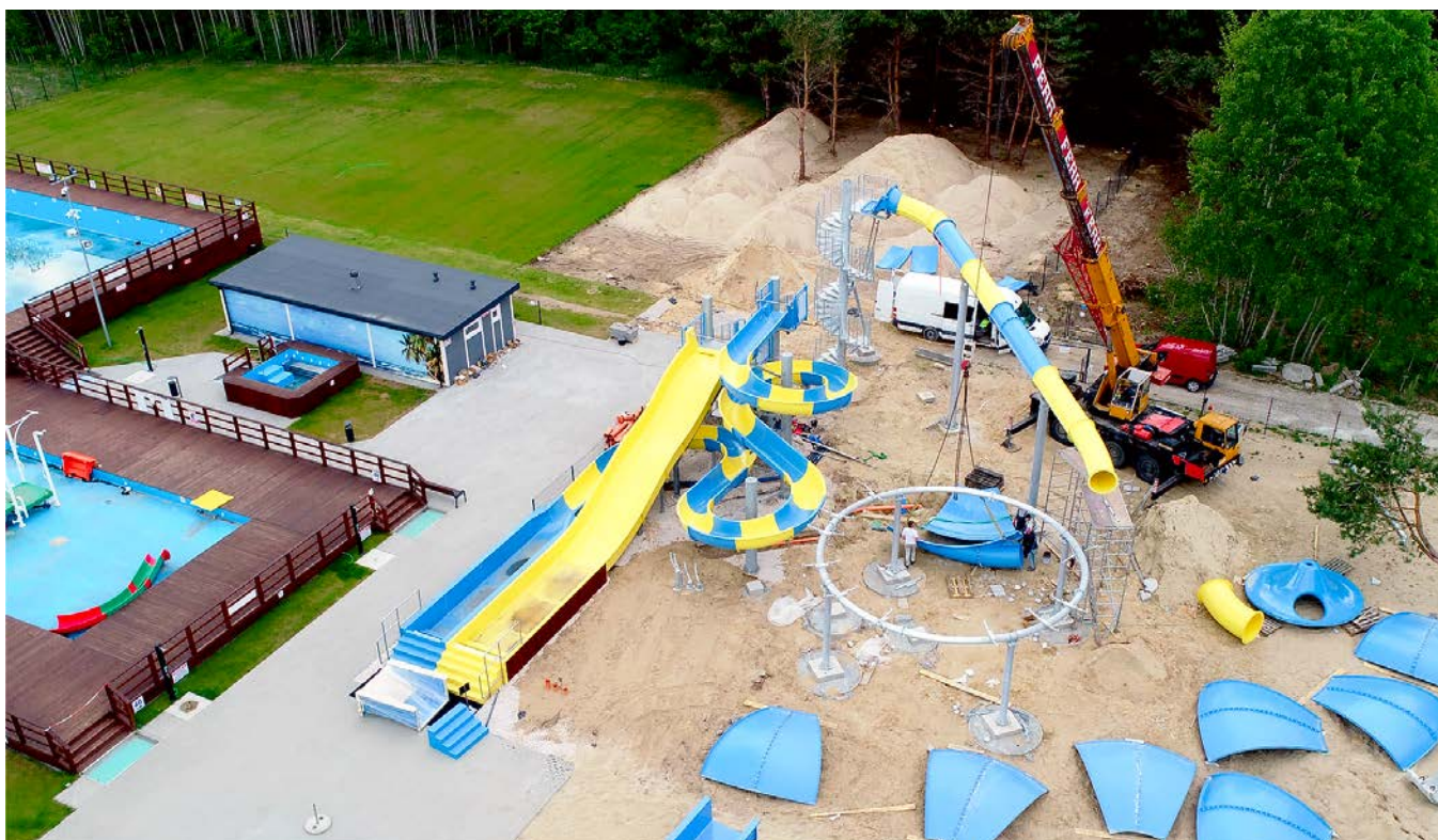
Baseny letnie w Strzeniówce – budowa nowej zjeżdżalni
