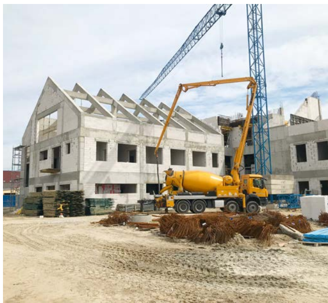
Budowa Zespołu Usług Komunalnych przy ul. Granicznej w Nadarzynie
