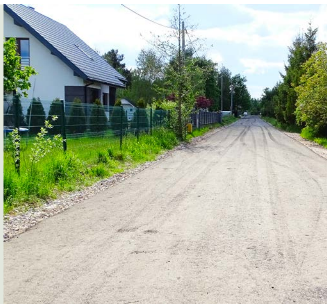
Naprawy i utwardzanie destruktem dróg gminnych
