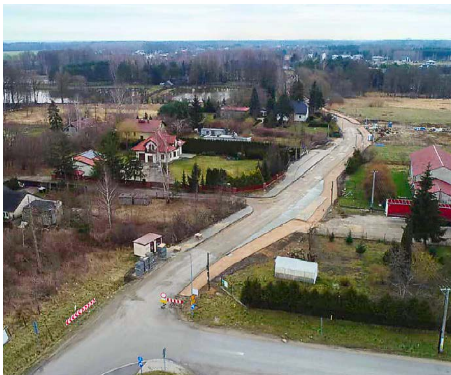
Przebudowywana ul. Główna w Ruścu
