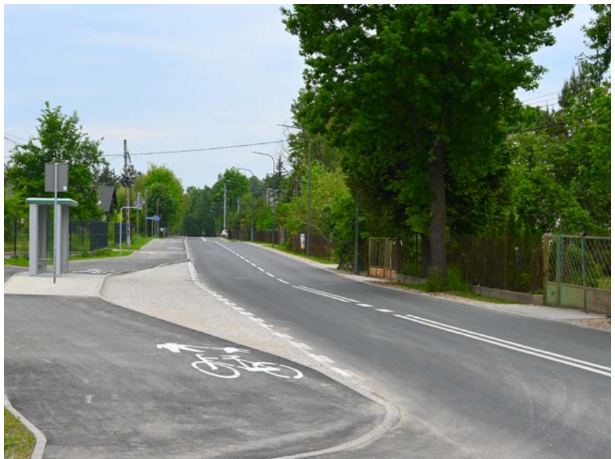
Wyremontowana ul. Główna w Ruścu
