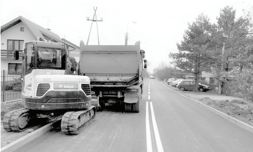
Remont ulicy Granicznej w Nadarzynie.
