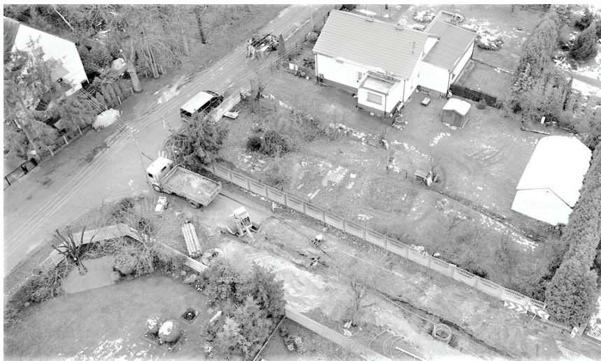
Rozbudowa istniejącej sieci kanalizacyjnej w aglomeracji Nadarzyn ul. Tulipanowa.
