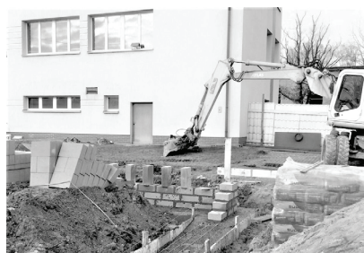
Prace przy budowie nowego skrzydła szkoły w Nadarzynie przy ul. Sitarskich.
