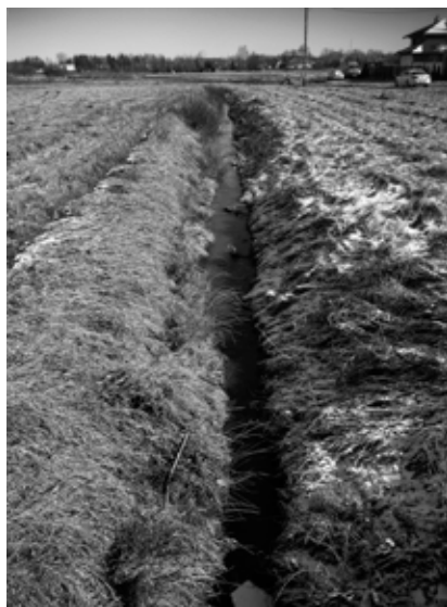
Rów przed oczyszczeniem
