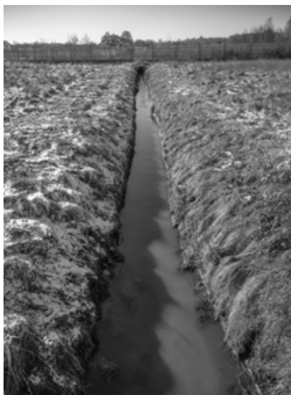
Rów po oczyszczeniu
